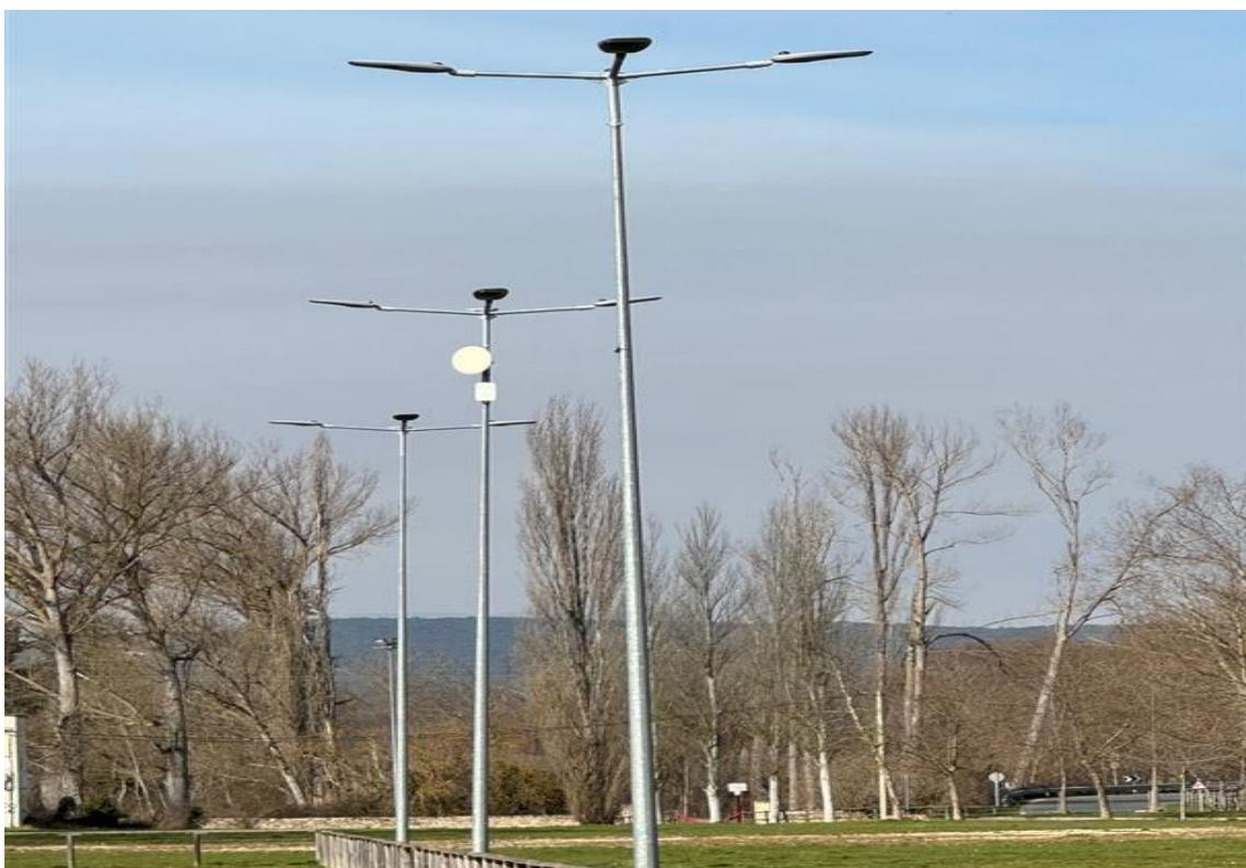
**Alumbrado Público LED en el Municipio de Villarcayo**, que supone la reforma y sustitución de las instalaciones de alumbrado exterior por tecnología más eficiente e incluyendo tele gestión. Con este proyecto, se pretende contribuir al desarrollo de un nuevo modelo energético para el municipio, mejorando los actuales servicios para los ciudadanos, permitiendo obtener y gestionar información detallada sobre consumos y materializando
